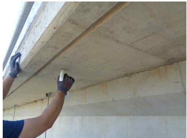
탄산화깊이 측정 현황
