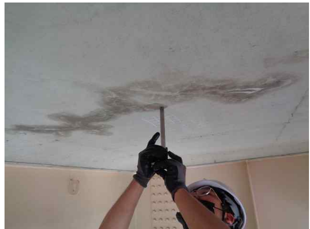
탄산화깊이 측정 현황
