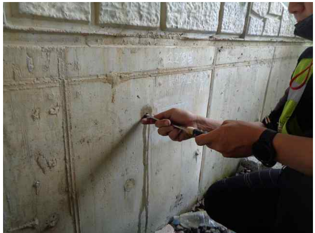
탄산화깊이 측정 현황
