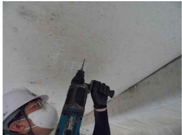
탄산화깊이 측정 현황
