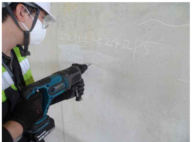
탄산화깊이 측정 현황
