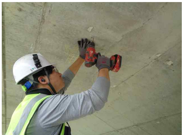
탄산화깊이 측정 현황
