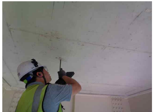
탄산화깊이 측정 현황
