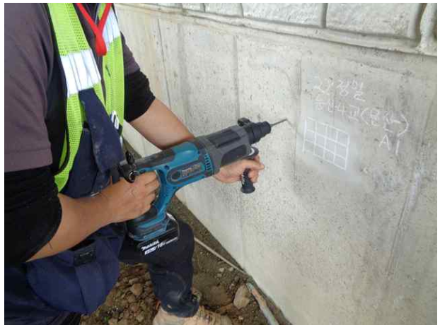
탄산화깊이 측정 현황
