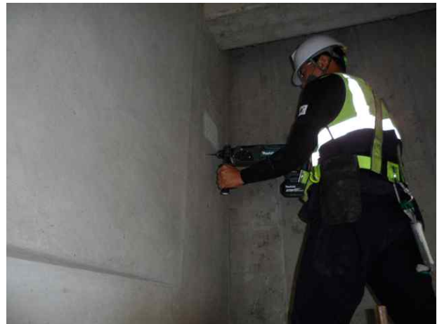
탄산화깊이 측정 현황
