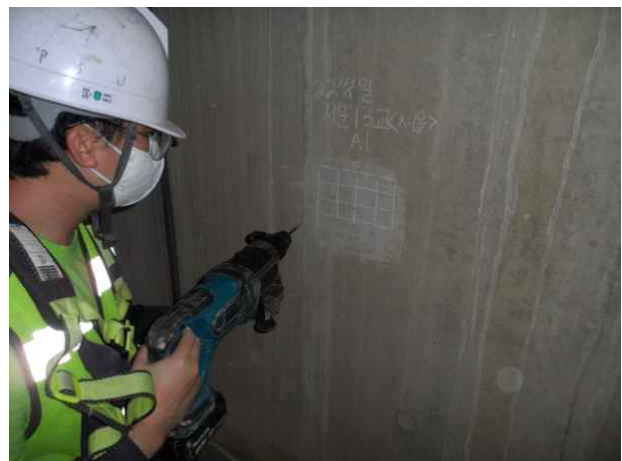
탄산화깊이 측정 현황
