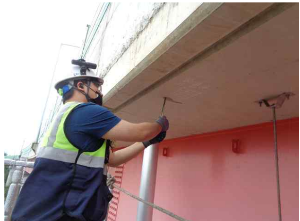
탄산화깊이 측정 현황
