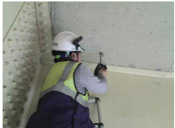
탄산화깊이 측정 현황
