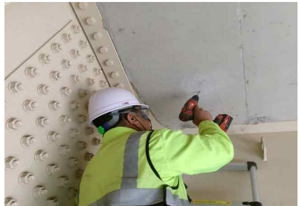
탄산화깊이 측정 현황
