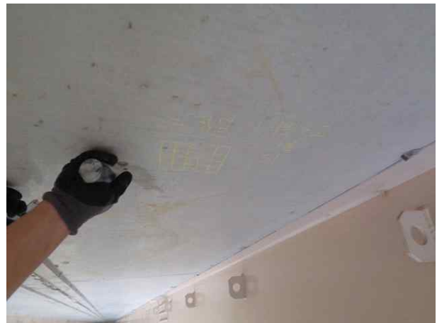
탄산화깊이 측정 현황
