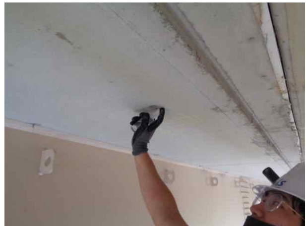
탄산화깊이 측정 현황
