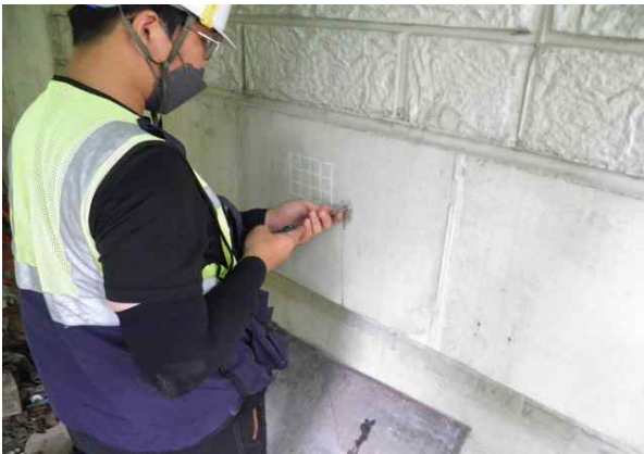
탄산화깊이 측정 현황
