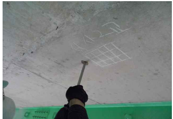
탄산화깊이 측정 현황
