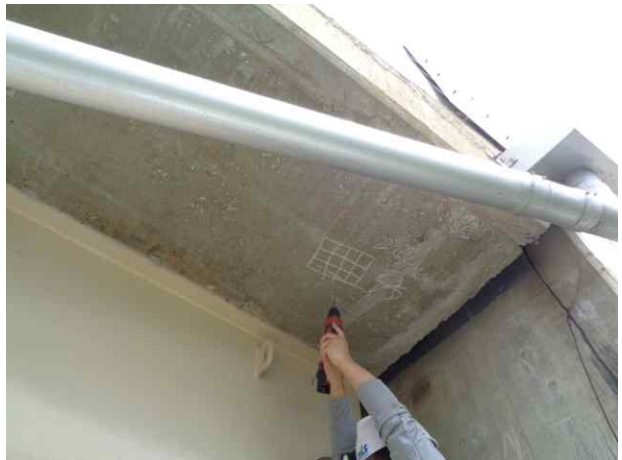
탄산화깊이 측정 현황
