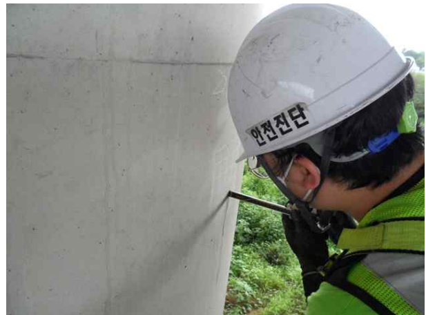
탄산화깊이 측정 현황
