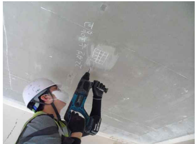
탄산화깊이 측정 현황
