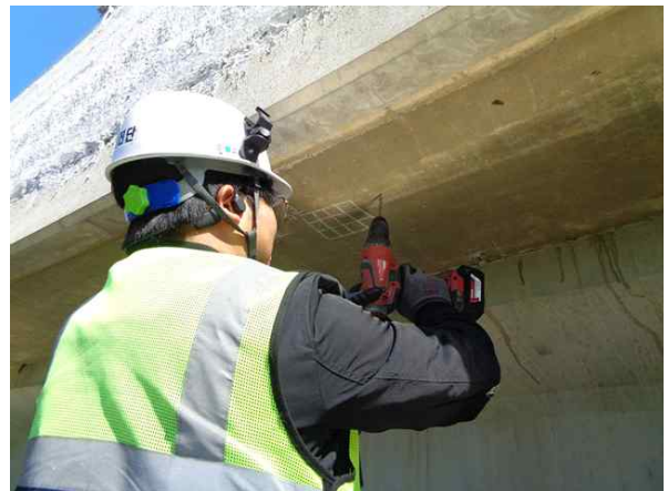
탄산화깊이 측정 현황
