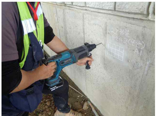
탄산화깊이 측정 현황
