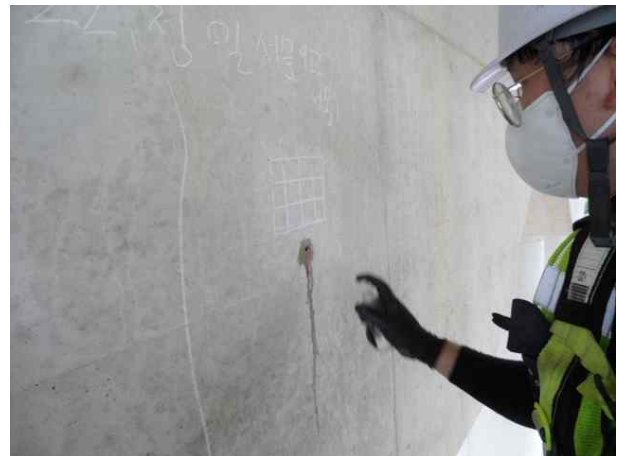
탄산화깊이 측정 현황
