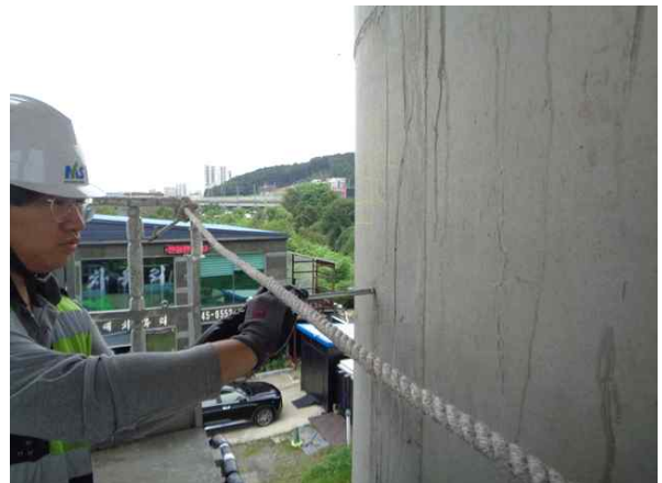
탄산화깊이 측정 현황
