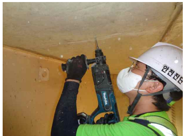
탄산화깊이 측정 현황
