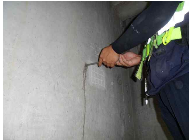
탄산화깊이 측정 현황
