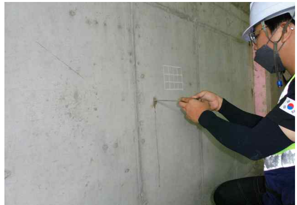
탄산화깊이 측정 현황
