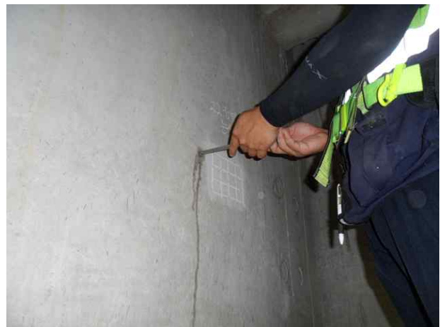
탄산화깊이 측정 현황
