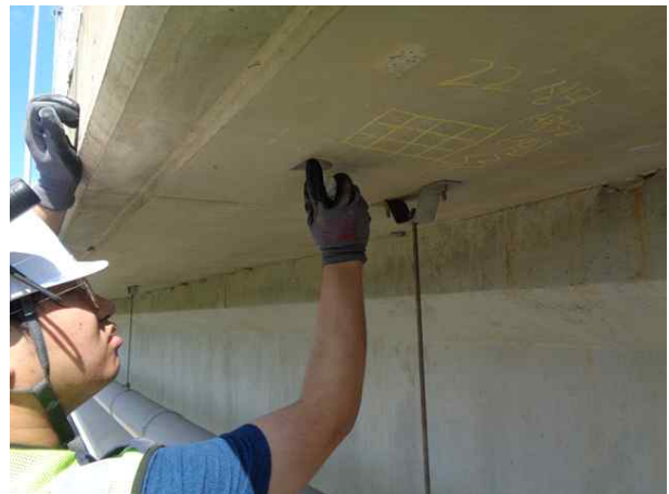
탄산화깊이 측정 현황
