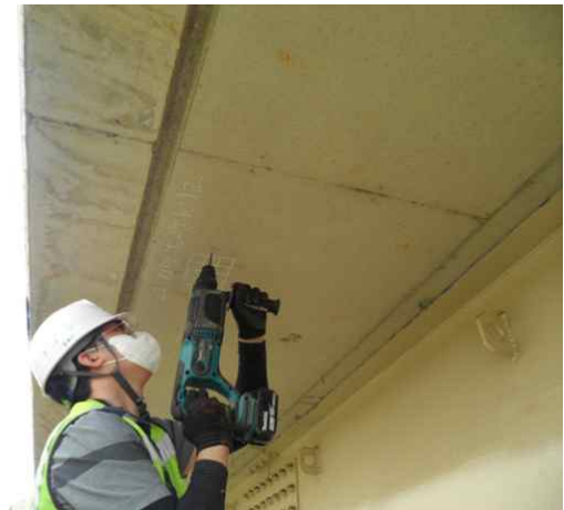
탄산화깊이 측정 현황
