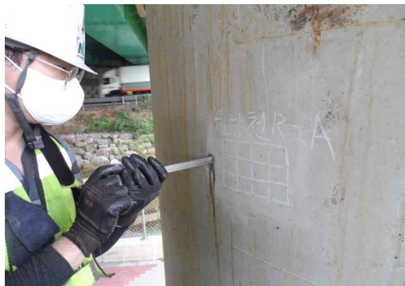
탄산화깊이 측정 현황
