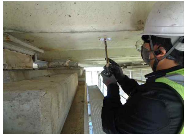
탄산화깊이 측정 현황
