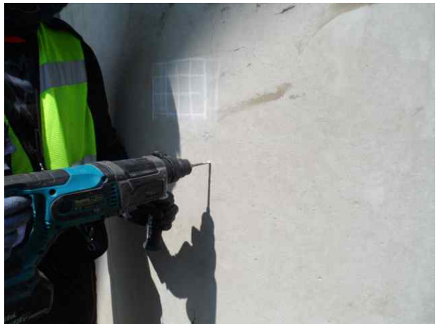
탄산화깊이 측정 현황
