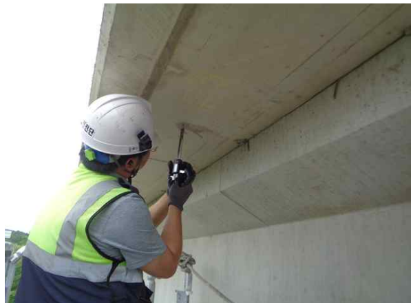
탄산화깊이 측정 현황
