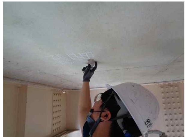
탄산화깊이 측정 현황
