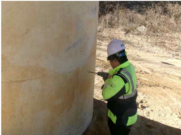
탄산화깊이 측정 현황
