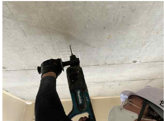
탄산화깊이 측정 현황
