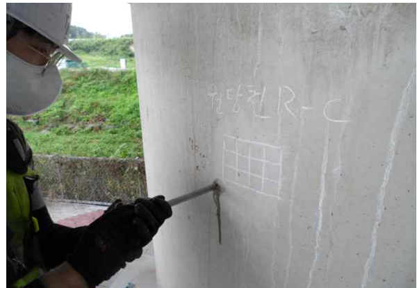
탄산화깊이 측정 현황
