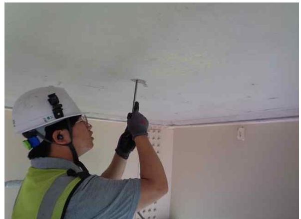
탄산화깊이 측정 현황
