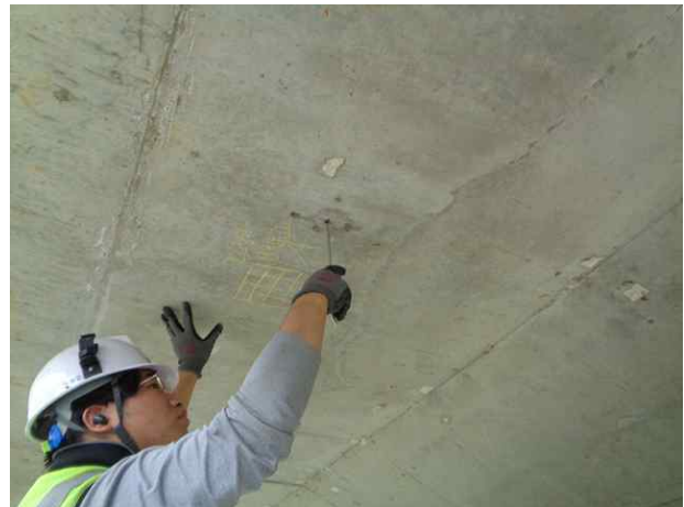
탄산화깊이 측정 현황
