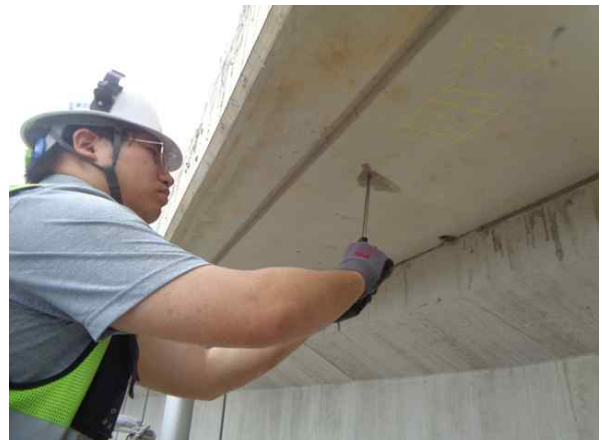
탄산화깊이 측정 현황
