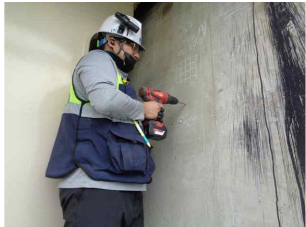
탄산화깊이 측정 현황
