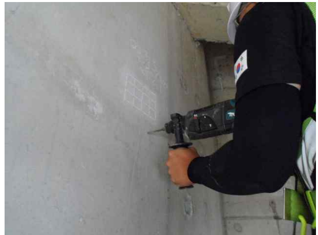
탄산화깊이 측정 현황
