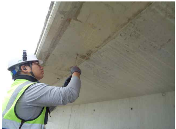
탄산화깊이 측정 현황
