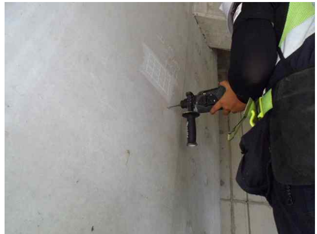
탄산화깊이 측정 현황
